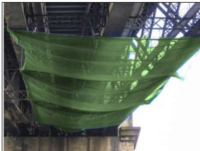
รูปที่ 2.7.7-5 ตัวอย่างการติดตั้งตาข่ายป้องกันเศษวัสดุตกหล่น (Safety Net)
