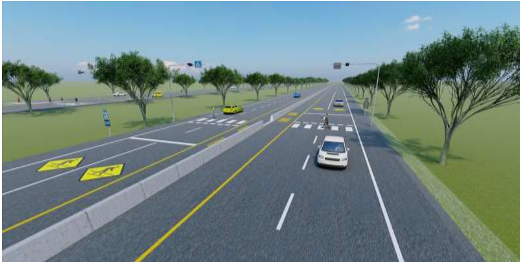
รูปที่ 2.6.2-3 รูปแบบตัดแต่งคอนกรีตสำหรับคนเดินข้าม
